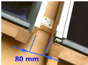
Ausgangszustand: Alle (erforderlichen) Montageschritte bei zweiter Reihe ausgeführt; Abstand = 80 mm
