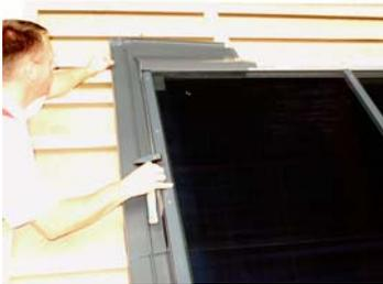
Ecke links oben montieren und mit Schiefernägeln außerhalb der Sicke befestigen.
