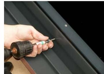
Seitenabdeckprofil (links und rechts) einschieben und mit a) befestigen.
