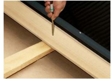
Links und rechts Spax durch Rahmen schrauben (unbedingt vorbohren!).
