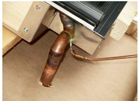
Cu-Anschlussverbinder aufstecken und anschl. durch hartlöten verbinden.
