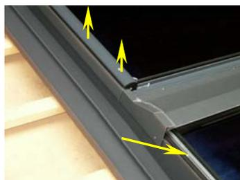
Abdeckprofile demontieren und Seitenabdeckprofile anbringen. Anschließend Abdeckprofile wieder festschrauben und Übergangsblech an vorgegeben Stellen mit a) befestigen.
