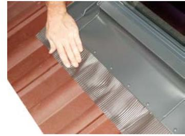
Anschließend Bleichsürze über gesamte Länge an Ziegelform anpassen.
