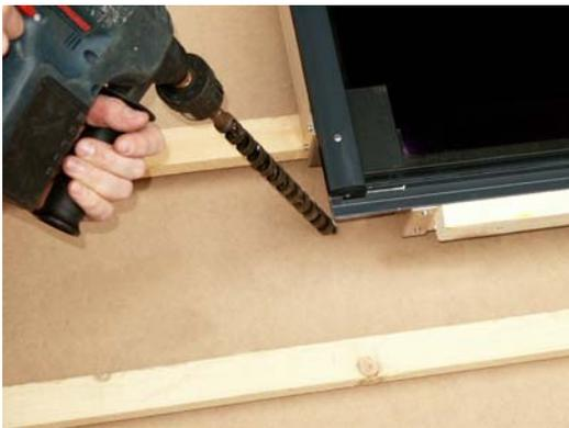
Bohren von Öffnungen um Anschlüsse in den Dachraum leiten zu können.
