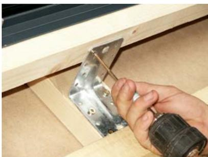
Modul mit Spax an Winkeln befestigen (Anzahl und Anordnung der erforderlichen Befestigungsmittel siehe Tab. S.11).
